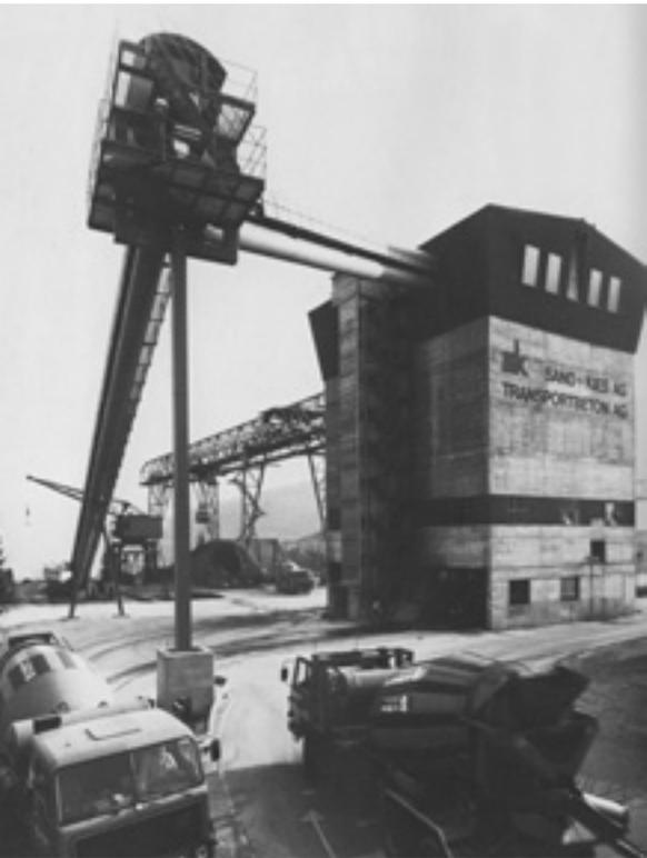
1972/73 wurde die Anlage modernisiert und eine der grössten Transportbetonfabriken der Schweiz mit vier Betonmischern erstellt.
