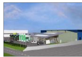
Südansicht des neuen Landi-Gebäudes. (Bild: zvg)
